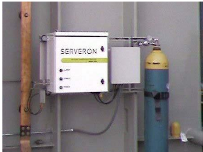
Figura 7: Montaje del monitor contra el tanque del transformador
