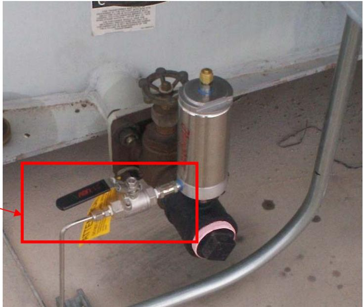
Figure 4 : Dispositif de purge installé
