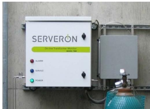
Figure 6 : Montage sur mur du moniteur pour transformateurs
