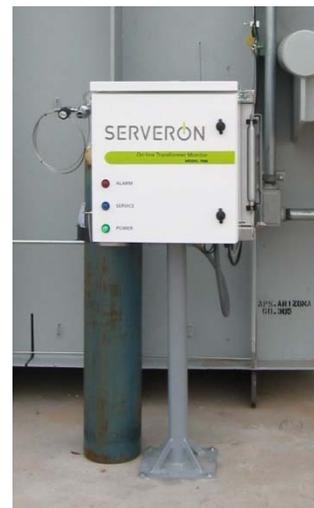
Figure 5 : Montage sur pied de socle
