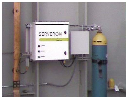
Figure 7: Montage sur réservoir du moniteur pour transformateurs
